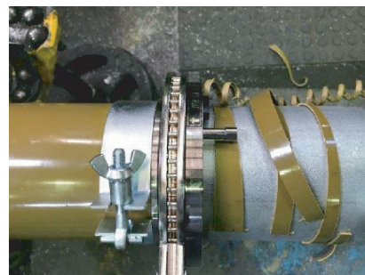
写真2 市販の剥離装置を使用した剥離状況
