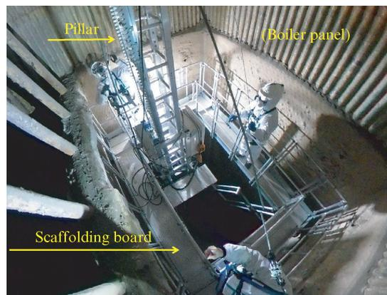
写真1 アンブレラ・デッキ<sup>®</sup>設置状況
