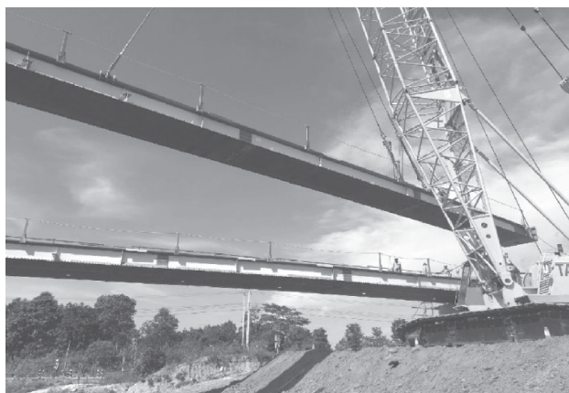
写真1 リバーブリッジ®地組立一括架設（ラオス） Photo 1 Girder erection by crane (Lao P.D.R)
