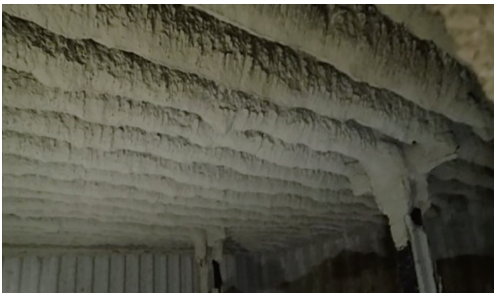
写真3 過熱器状況 (SPS 適用前, 蒸気式ストブブロウ)
