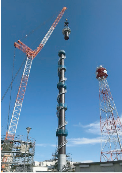
写真3 鉄骨建方状況 Photo 3 Steel frame erection
