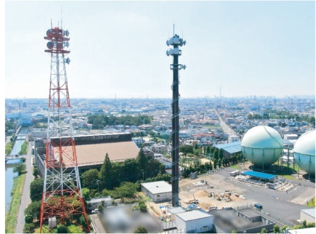
写真4 第1号機の外観写真 Photo 4 Appearance of first project
