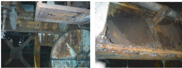
写真1 加熱炉トラブル事例
