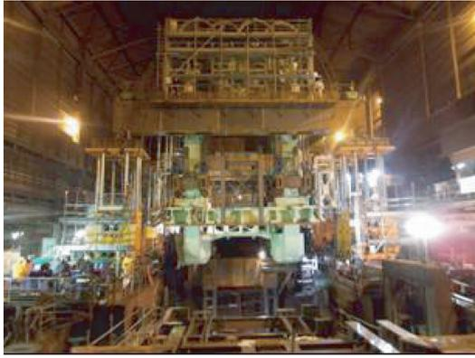
写真3 ハウジング一体ジャッキダウン開始
