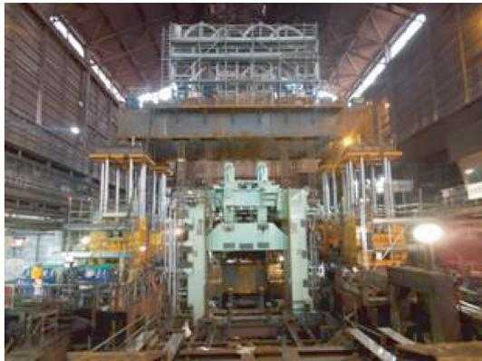
写真4 ハウジング一体ジャッキダウン完了
