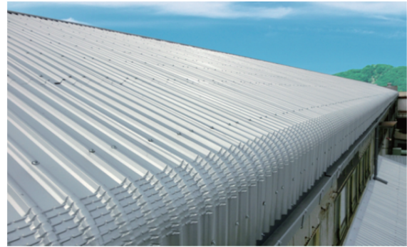
写真4 「スレートカバー 650 ® 」の改修事例 Photo 4 Construction example of "SLATECOVER650"
