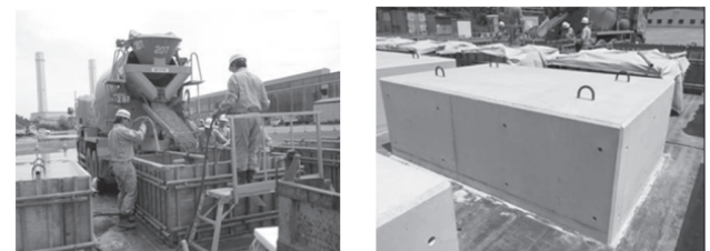
図4 方塊ブロックの製造状況
