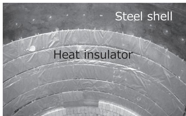
写真1 断熱材の鉄皮内面への施工状況
