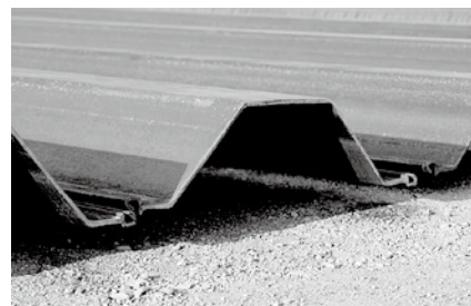
写真2 ハット形鋼矢板 Photo 2 Hat-shaped steel sheet piles
