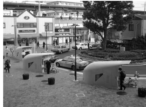
写真2 地下式駐輪場
