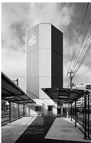
写真1 地上式駐輪場
