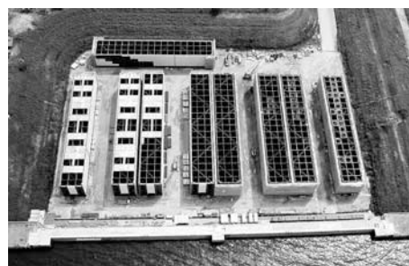
写真3 衣浦港廃棄物処分場向け ハイブリッドケーソン Photo 3 Hybrid caisson for Kinuura Reclaimed Ground
