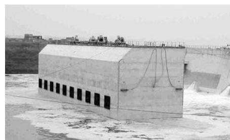
写真2 敦賀発電所護岸向け ハイブリッドケーソン Photo 2 Hybrid caisson for Tsuruga Power Plant
