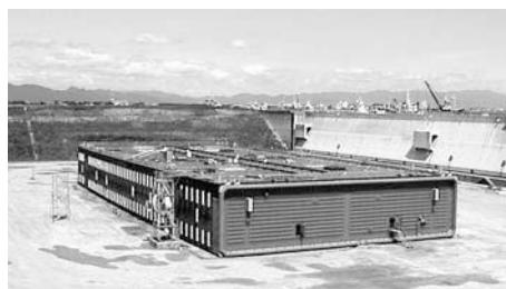
写真1 那覇港トンネル向け 沈埋函 Photo 1 Immersed tube for Naha Port Tunnel
