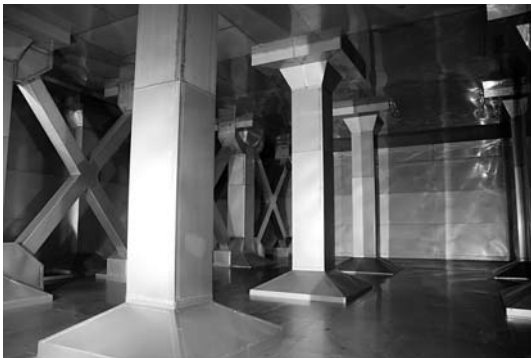
写真 1 矢坂山配水場 1 号池耐震補強工事完成状況
