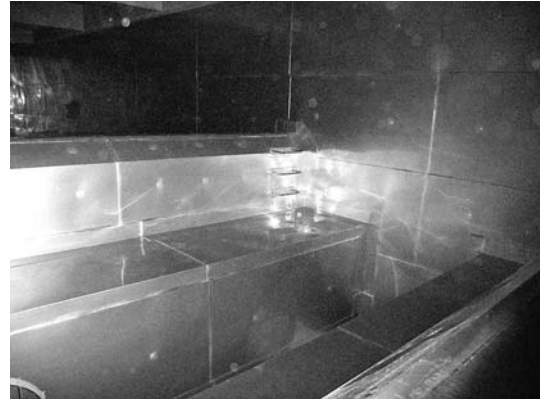
写真 2 連絡渠および流入渠表面保護工完成状況
