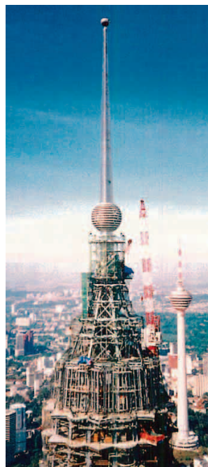
写真 2 リフトアップ完了
