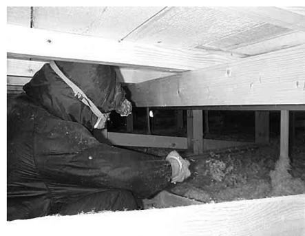
写真2 ロックウール吹込み用断熱材の施工状況
