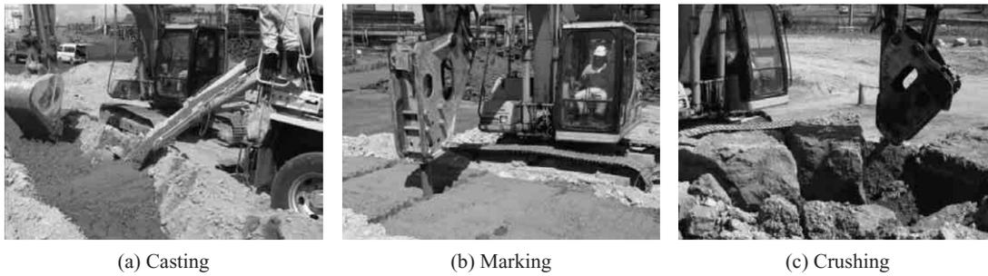
写真1 打設, 破碎作業
