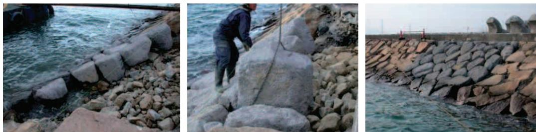
写真3 護岸補修工事
