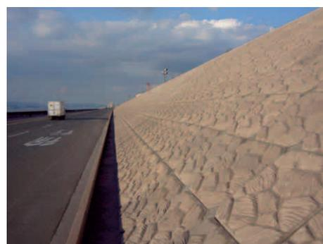
写真 4 フェロフォーム製ブロックを用いた防潮堤
