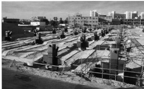
写真1 柱-杭接合部の施工状況
