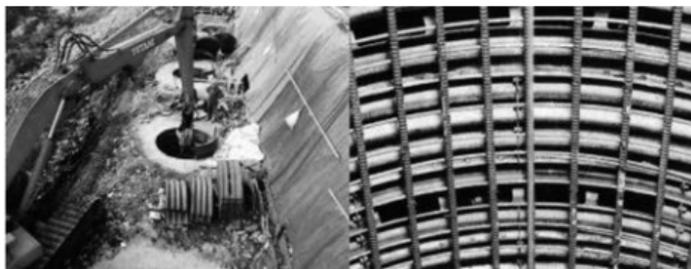
深礎本体コンクリートの打設によってコンクリートが、余堀部に流出し裏込め作業も同時に行われます。
