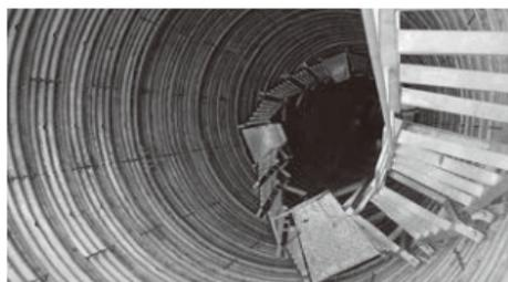
集水井内部には点検用の階段を取り付けます。
