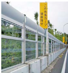
先行反射波と遅延進行波の干渉による減音
