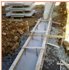
壁面の基礎部
