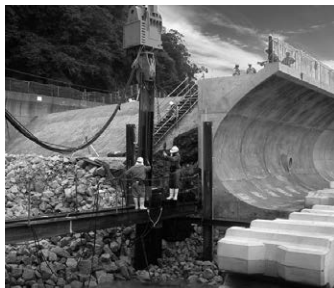
鋼矢板の事例
