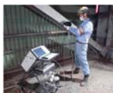
構造物検査の例
