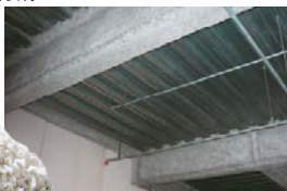
鉄骨耐火被覆施工例
