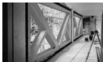
柱付鉄骨ブレース工法
