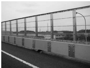
道路・トンネル
