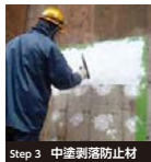
Step 3 中塗剥落防止材
