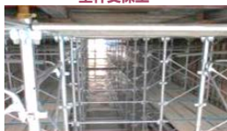
布材 3ステップ施工
