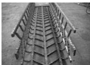
部材に合わせて工場で曲げ加工
