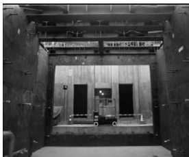
7T-MRI 磁気シールド鉄板工事写真 (EFE材：電磁用軟鉄、約500 ton)
