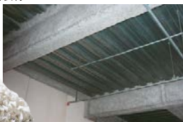
鉄骨耐火被覆施工例
