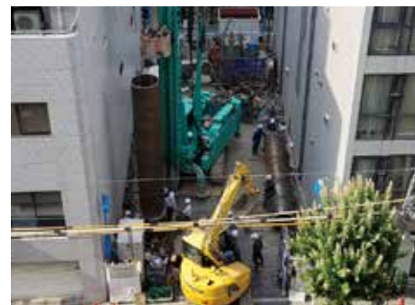
杭建込み状況
