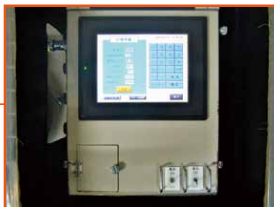
杭工事管理者用モニターの例
