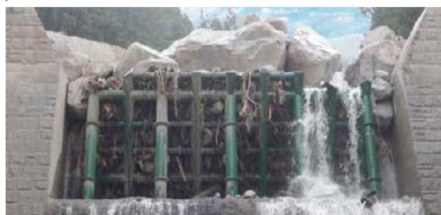
J-スリット<sup>®</sup>堰堤による土石流補足
