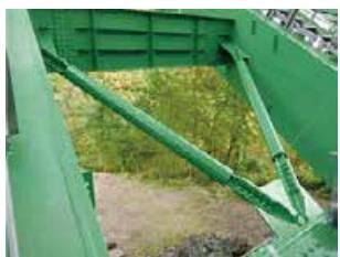
橋脚耐震補強施工例
