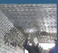
格子鋼板筋によるRC橋脚等の補修・補強工法です。
