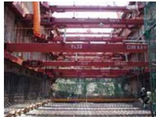
Ecoラム® 工法 道路函渠工事
