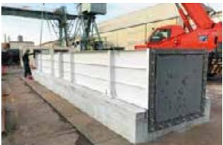
プレキャスト防水壁 (鋼製)
