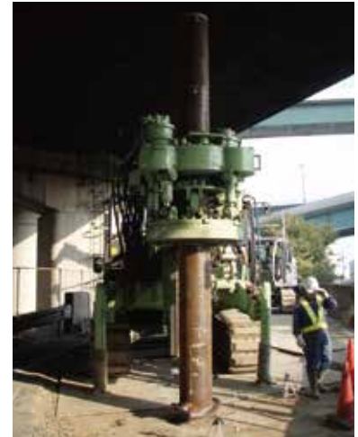
低空頭・狭隘地施工
