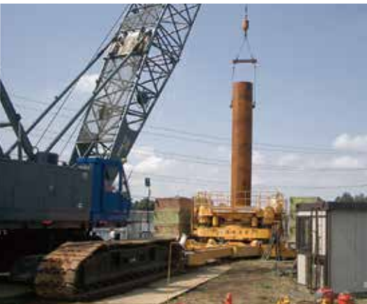
施工状況(全周回転機)
