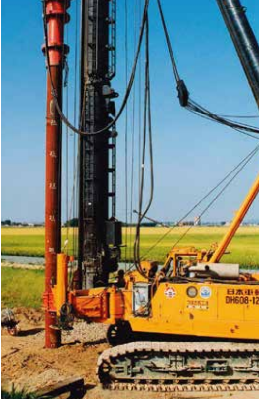
施工状況(クローラ式杭打機)
