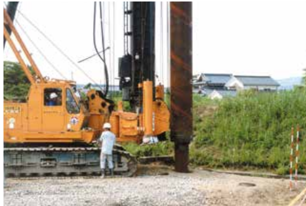
拡頭杭の施工
