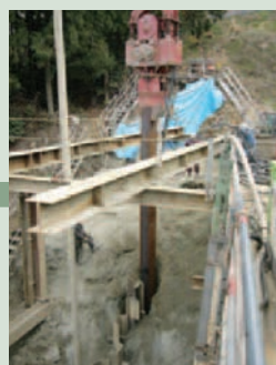
●バイプロハンマによる打設
