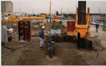
●コーナー施工
