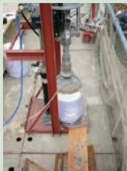
●高圧ポンプセット
