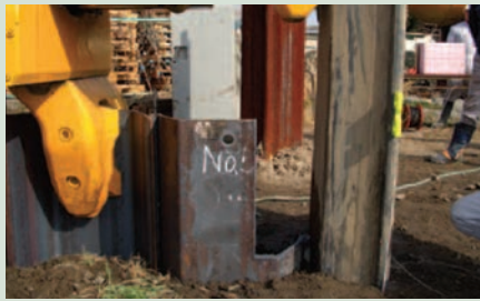
●コーナー・ラップ施工
