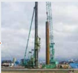
掘削攪拌(ソイルセメント柱造成)
