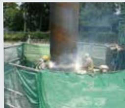
鋼管溶接(継杭の場合)
