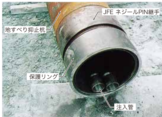
PIN継手用保護リングの取付状況
