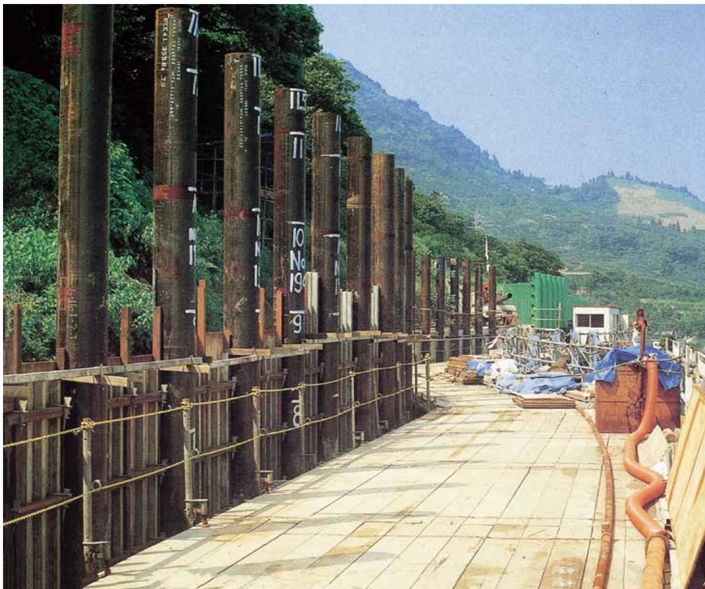
斜面地すべり対策の事例
