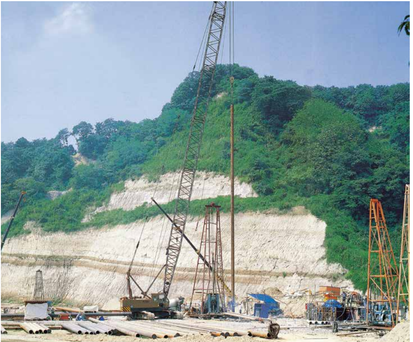
斜面地すべり対策の事例
