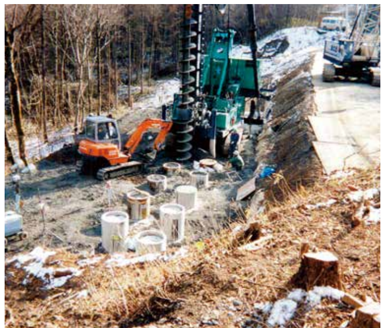
道路災害対策の事例
