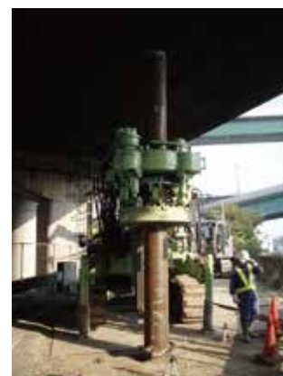
空頭制限下での施工
