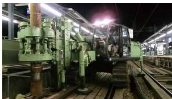
線路内での急速施工の事例
