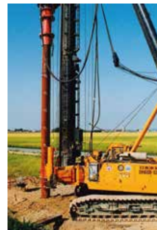
三点杭打機での施工
