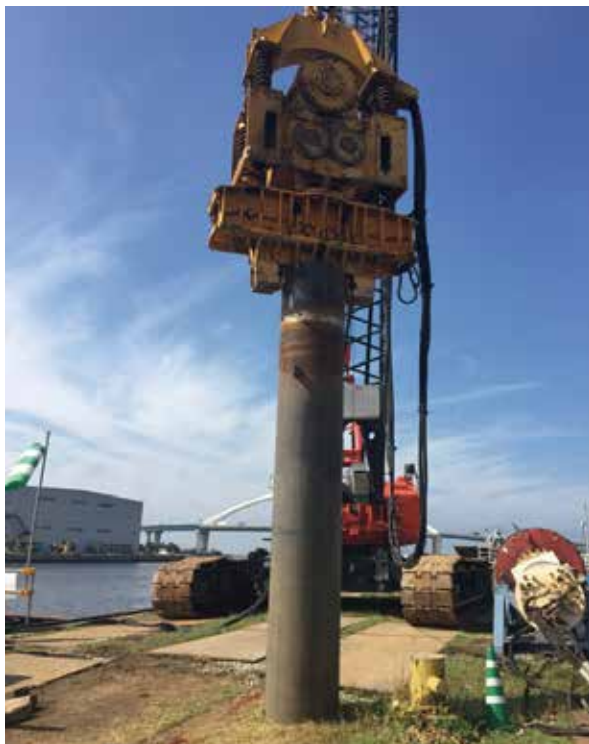
機械式継手付鋼管杭の打設
