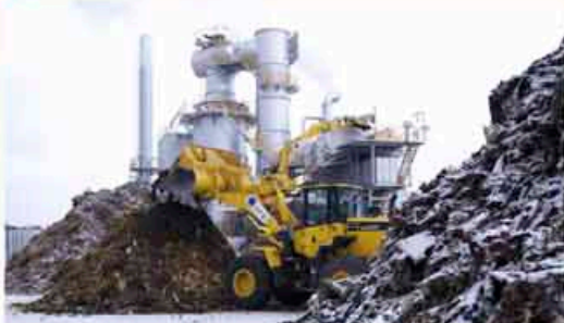
ロータリーキルン炉（処理能力：90t/日）
