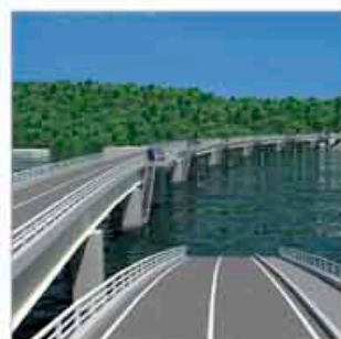
避難路付高架橋
