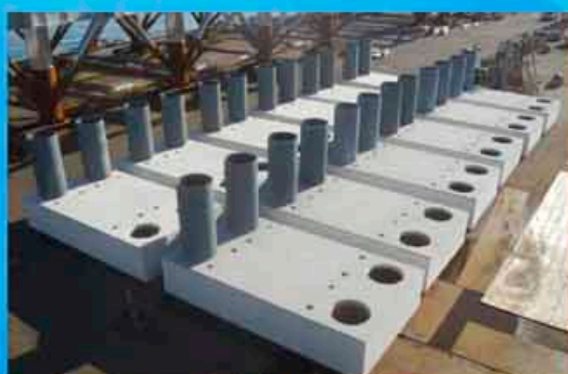
堤体ブロック製作
