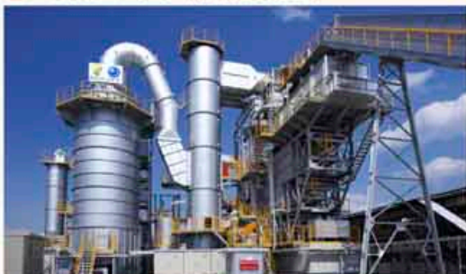
ストーカ炉（処理能力：95t/日×2炉）
