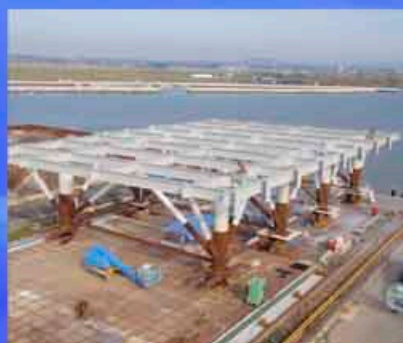
石巻漁港ジャケット式栈橋
