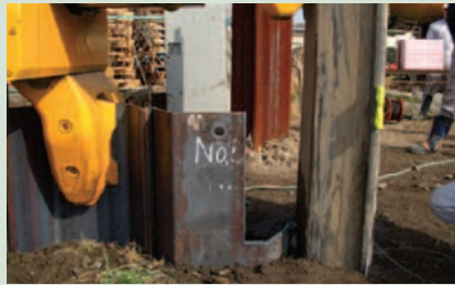
●コーナー・ラップ施工
