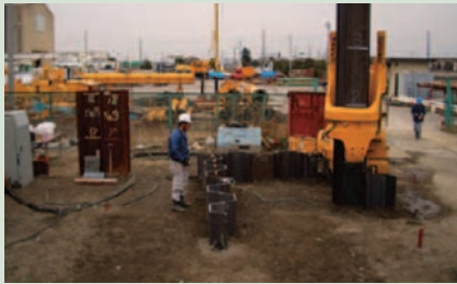
●コーナー施工
