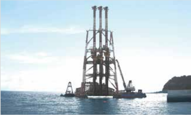
サンドコンパクションパイル(海域)
