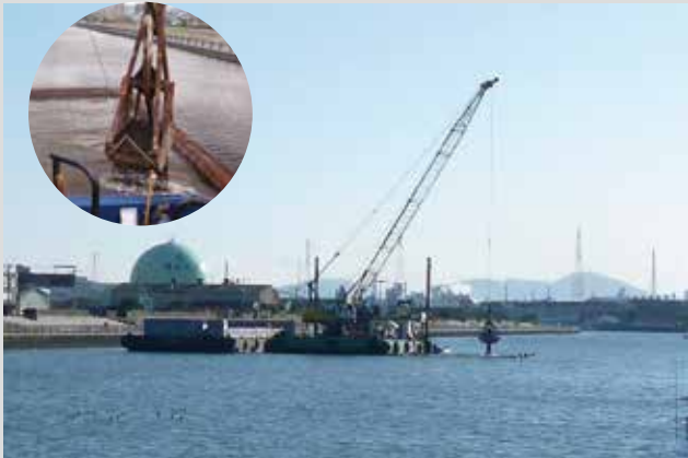
マリンスターン®施工状況
