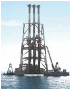
サンドコンパクションパイル工 (海域:粘性土地盤)
