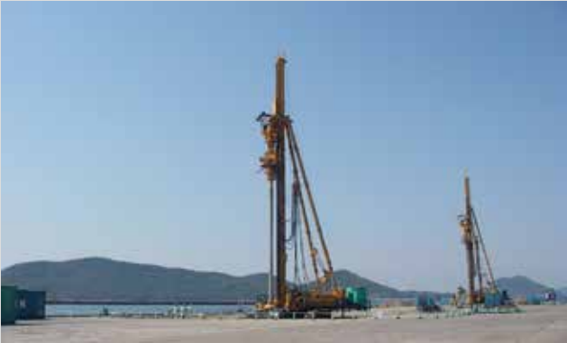
サンドコンパクションパイル(陸域)
