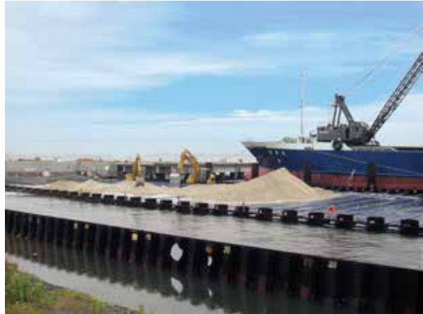
岸壁での施工例
