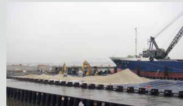
岸壁(土工用水砕スラグ)
