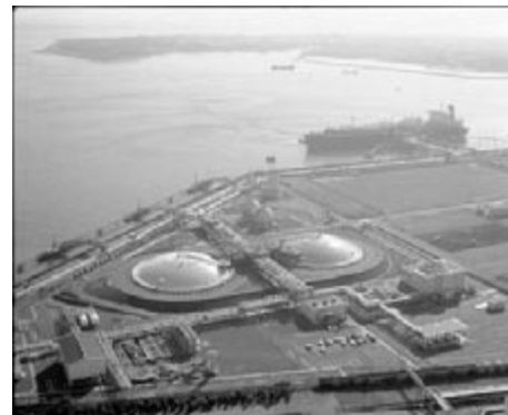
Photo2 LNG receiving terminal
