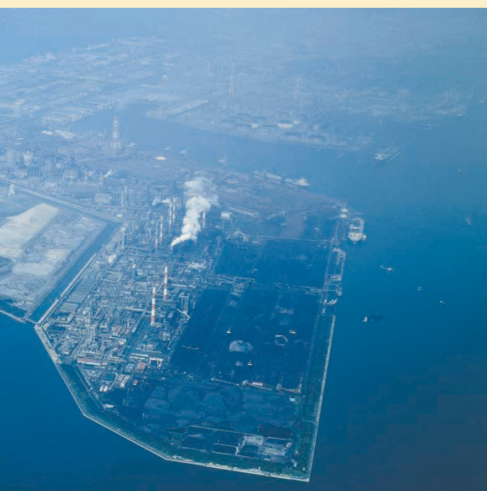
West Japan Works (Kurashiki)
