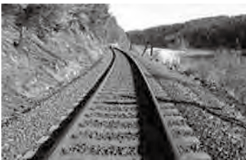
写真1 『SP3』の敷設場所
