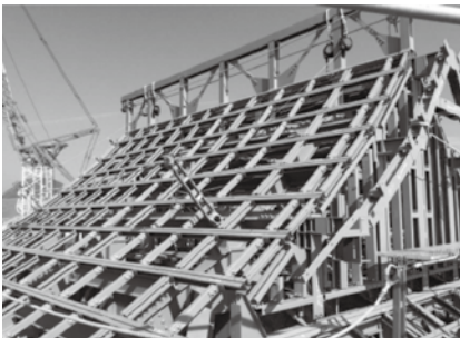
図2 熊本城大天守6階鉄骨造の外観
