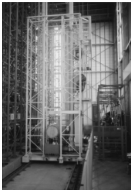
写真3 自動搬送設備
