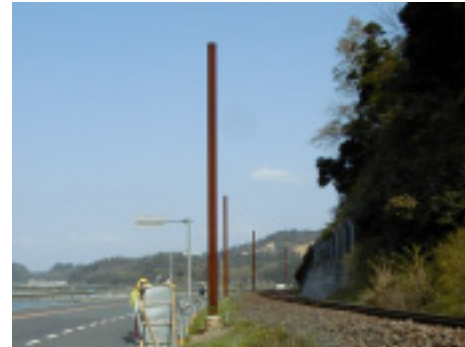
写真 1 海岸耐候性電縫鋼管を使用した架線柱設置状況 (小浜線)
