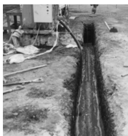
写真3 スラリー土打設
