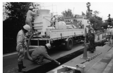
写真7 スラリー土打設
