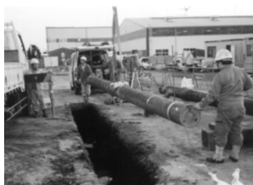
写真2 管吊り下ろし
