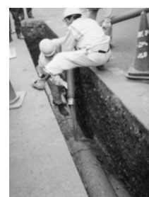
写真6 スラリー土吐出
