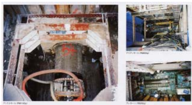
写真5 推進工事施工例
