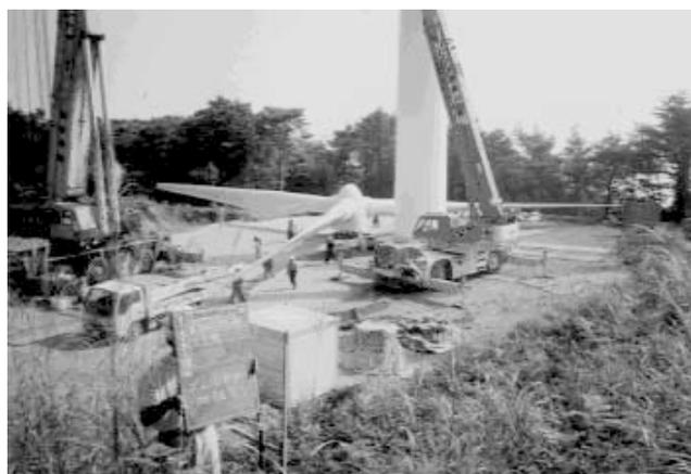
写真2 ロータ・ブレードの地組み
