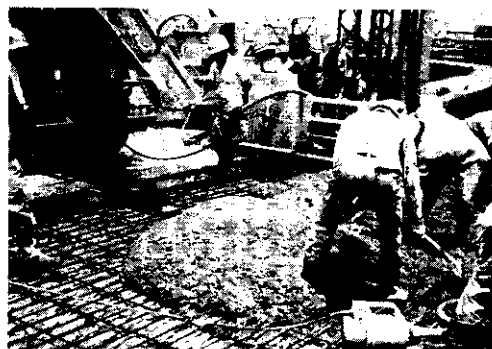
写真3 SFRCの打設
