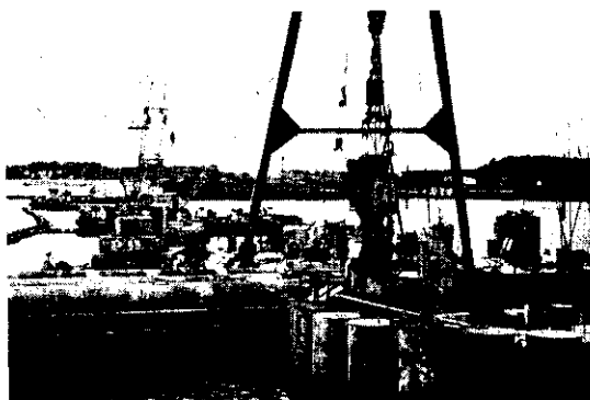
写真10 水中切断後撤去作業
