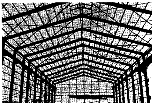
写真 1 山形タイプ施工例
