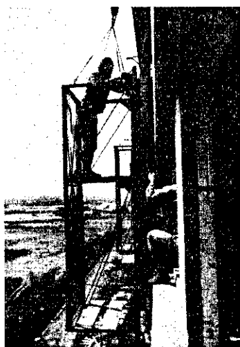
写真9 柱コンクリート型枠組立
