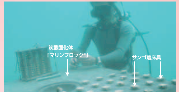
マリンブロック®へのサンゴ着床具設置の様子
