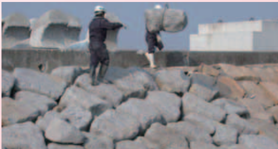
被覆石として利用されている水和固化体「フロンティアロック®」
